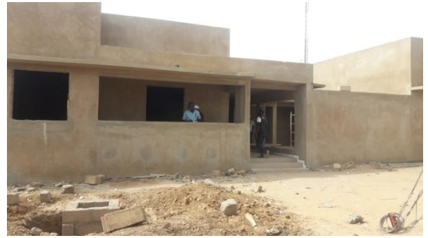
Construction SDELPA de Kanel
