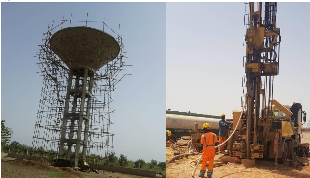
Photo : Travaux de construction de château d'eau (gauche) et de forage (droite) à Bouchra Ndawène
